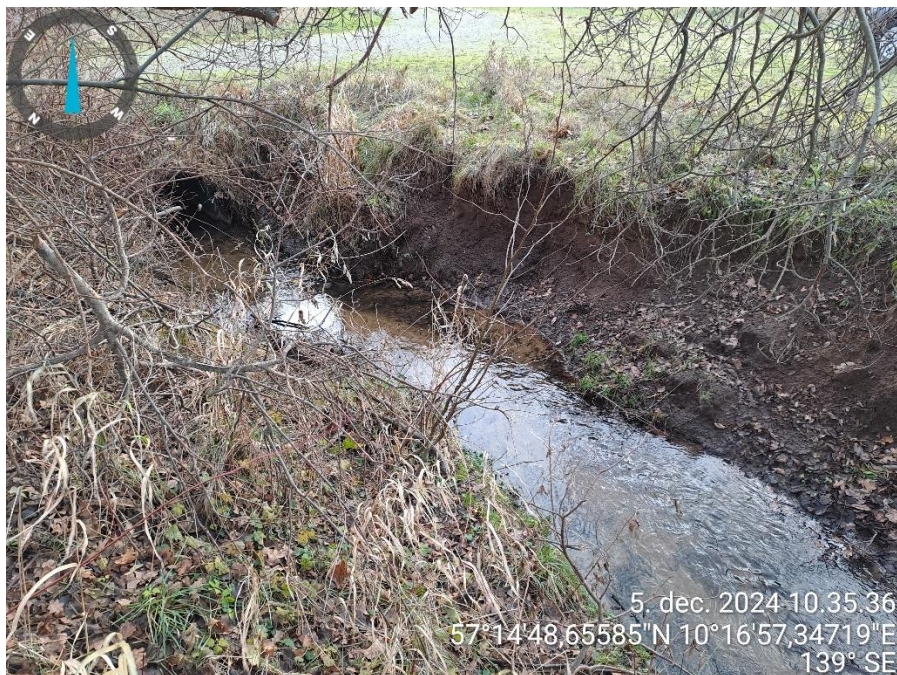
Figur 3, Strækning opstrøms røroverkørsel.
