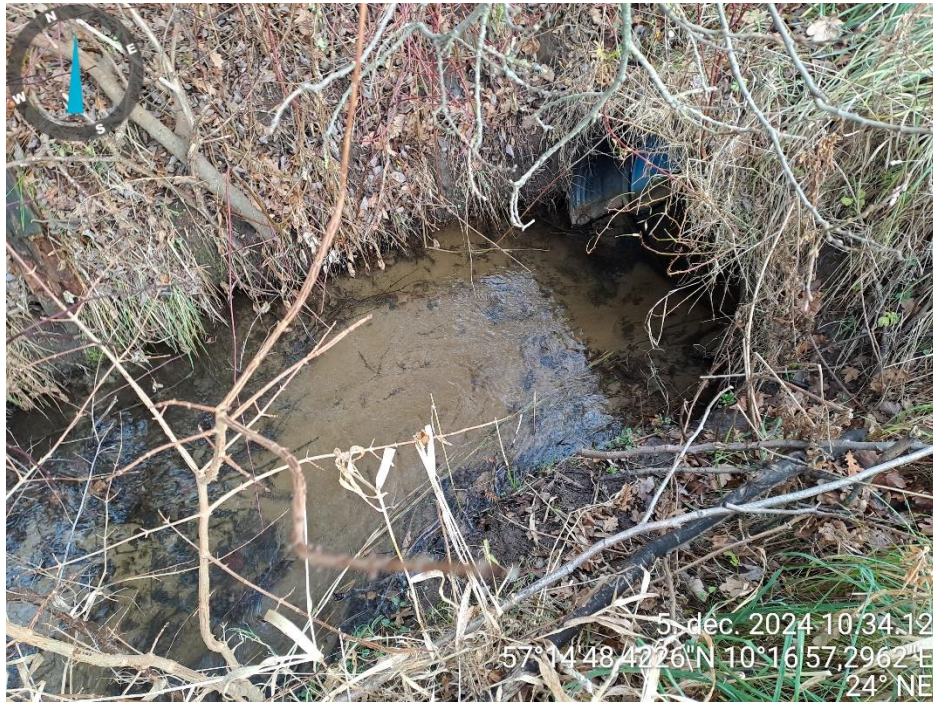
Figur 2, Røroverkørsel ved vandløbsstation 230 m set fra opstrøms retning.
